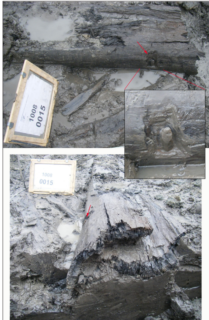
Afb. 44. Het duikerrestant S13 in detail. Hierop zijn de palen te zien die zijn gebruikt om de duiker op zijn plaats vast te zetten. De rode pijl geeft de locatie aan van één van de houten pennen die zijn gebruikt om de helften met twijgen op elkaar te bevestigen. In de inzet is de houten pen in detail weergegeven. Onder is te zien dat de duiker uit twee helften bestond.
